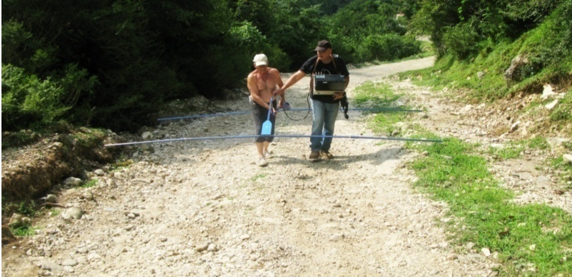
ნახ. 3. მდ. ხობისწყლის ხეობაში გამავალი საავტომობილო გზა, რომლის 150 მ სიგრძის მონაკვეთზე ჩატარდა პირველადი გეორადიოლოკაციური გამოკვლევები
